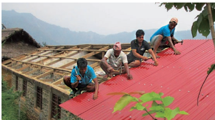
校舎屋根の修繕に一致協力する地元住民（ネパール）
